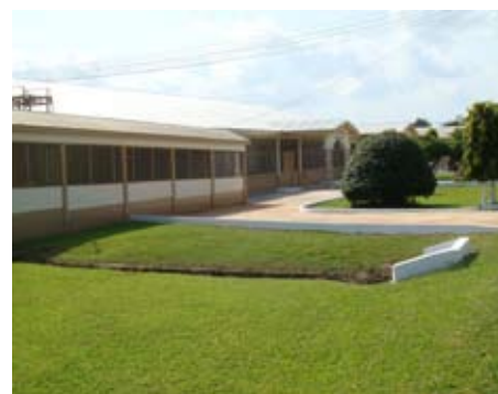
Een gedeelte van het orthopedische ziekenhuis dat met hulp van vele sponsors de laatste acht jaren is gebouwd. In november 2007 werd het beddenpaviljoen (laatste gebouw links) geopend. Op de voorgrond staat de operatieafdeling met twee volledig geoutilleerde operatiekamers
